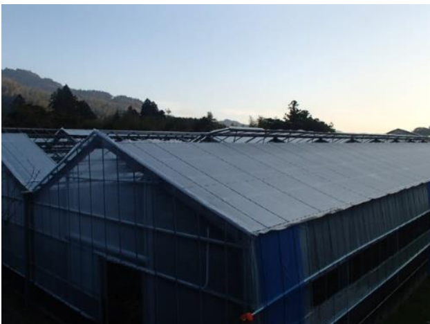
リフォームした施設
