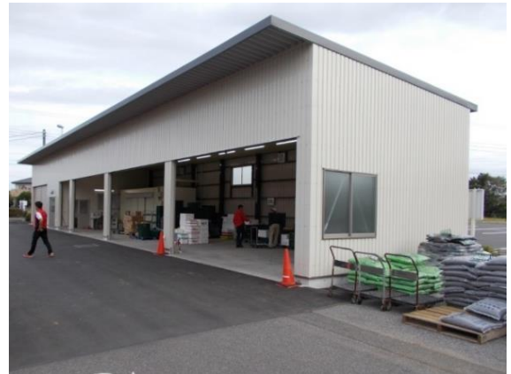
集出荷場外観
