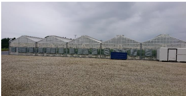
産地パワーアップ事業を活用した 1棟/20アールの鉄骨ハウス
