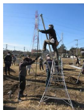
高所作業の様子
