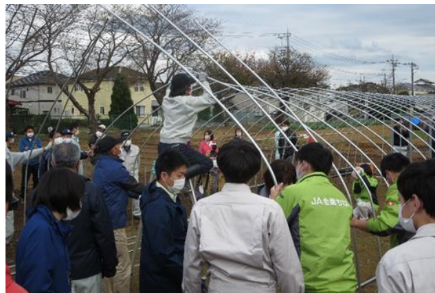
自力施工の実習の様子
