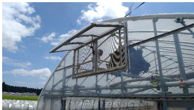
写真2 妻面上部への換気窓の設置
