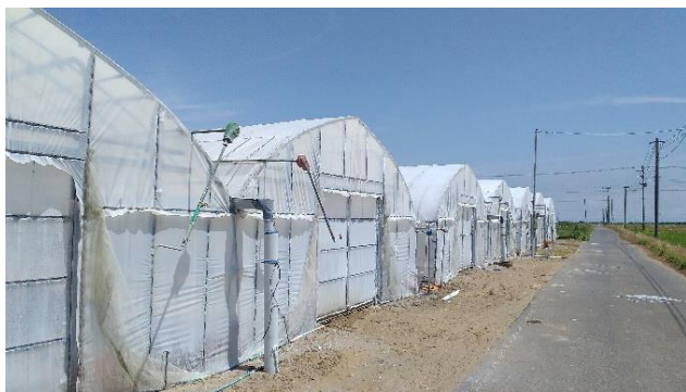
写真1 遮光・遮熱ペイント剤の散布塗布
