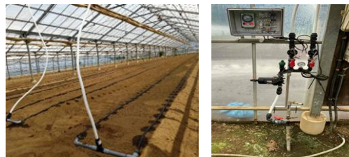
図3 自動かん水装置の例 (左) ベッドに合わせてポリパイプを塩ビ管で配管 (右) 電池式タイマー
